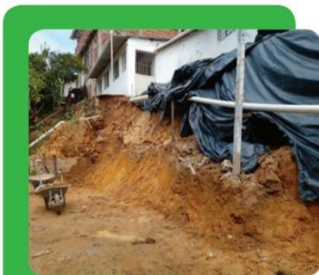
OBRA DE SOLO CIMENTO ENSACADO, RIP RAP Linha do Tiro
