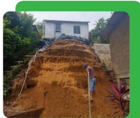
OBRA DE REVESTIMENTO ALVENARIA ARMADA Jardim Monte Verde
